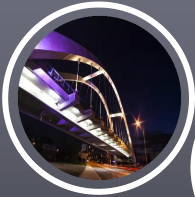
Budujemy drogi, obwodnice i mosty
