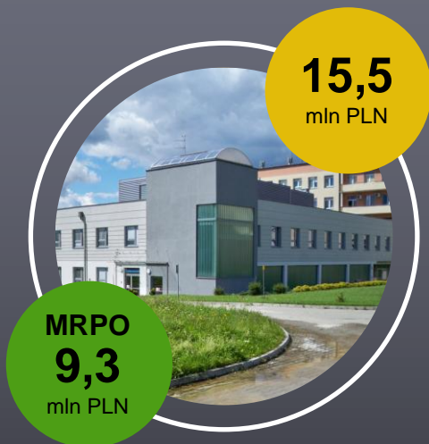
Budowa i wyposażenie sal operacyjnych Zespołu Opieki Zdrowotnej w Dąbrowie Tarnowskiej
