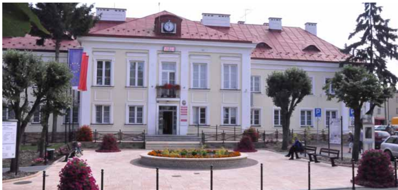
Urząd Miejski w Dąbrowie Tarnowskiej - I etap rewitalizacji Rynku
