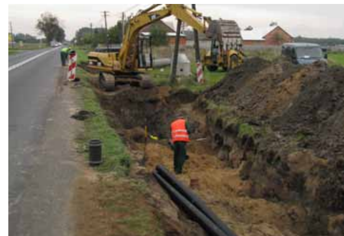
Budowa kanalizacji w ciągu ul. Żabińskiej w Dąbrowie Tarnowskiej
