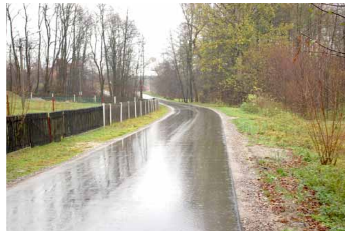
Nowa nawierzchnia drogi we wsi Brnik
