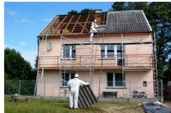
Wymiana azbestowych pokryć dachowych realizacja jest przy współudziale Funduszu Szwajcarskiego
