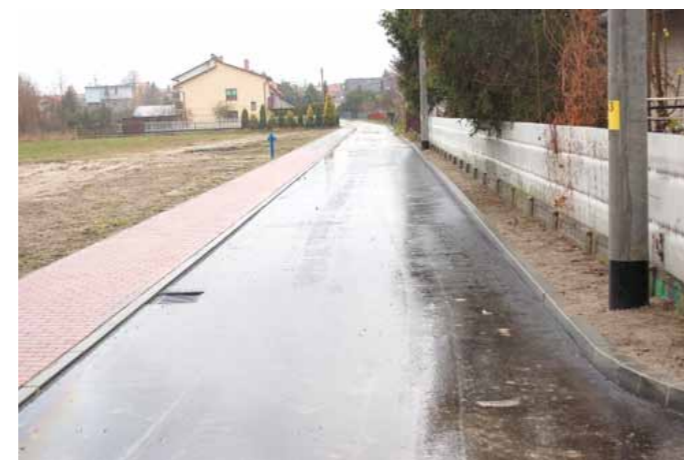
Nowa nawierzchnia ul. Kukiel
